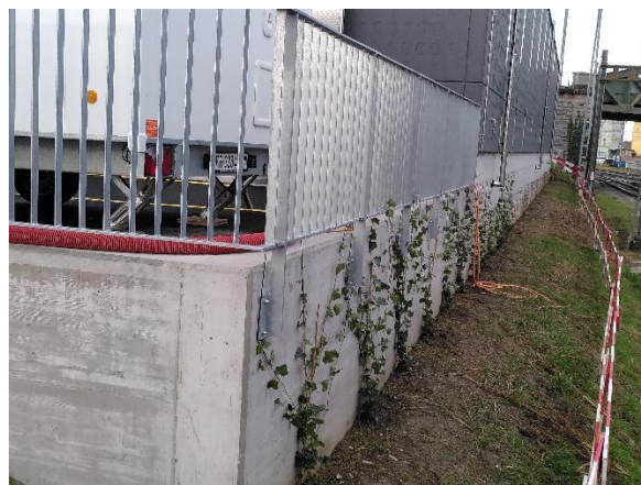
Habillage du mur de soutènement du bâtiment de service par des plantes grimpantes.
